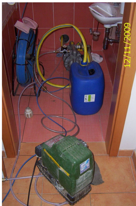
Obrázok č.9 Plnenie kvapaliny do systému
