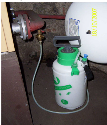
Obrázok č.16 Plnenie kvapaliny do systému
